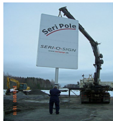
Figur 15 - Masten løftes hen over fundamentets hul.
