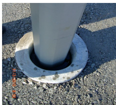
Figur 18 – Afstandsklodserne slås i.
