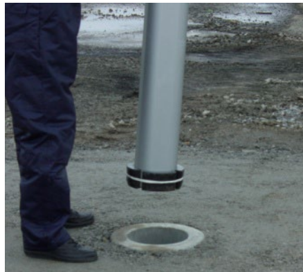
Figur 16 - Masten holdes i den rigtige vinkel i forhold til fundamentet idet masten nedsænkes.
