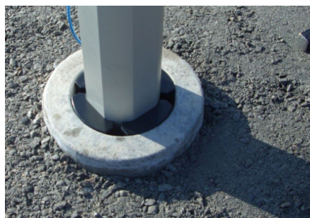
Figur 17 - Afstandsklodserne monteres løst i fundamentet.
